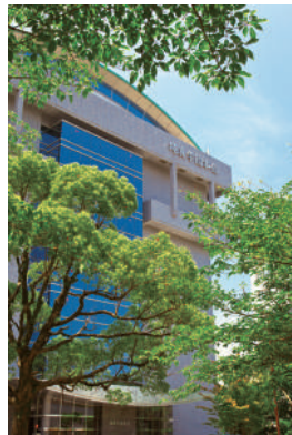
②左側、ドーム屋根の建物が本館です
